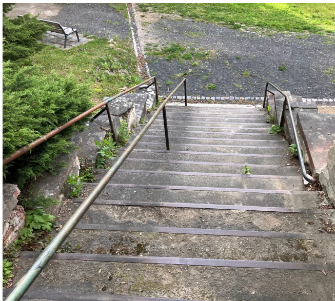
Z0.7 k odstranění a osazení nového středového madla
