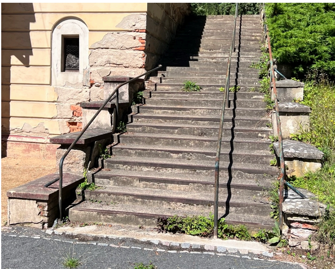
stávající schodiště k odstranění a nahrazení kamennými schodišti s žulovými stupni
