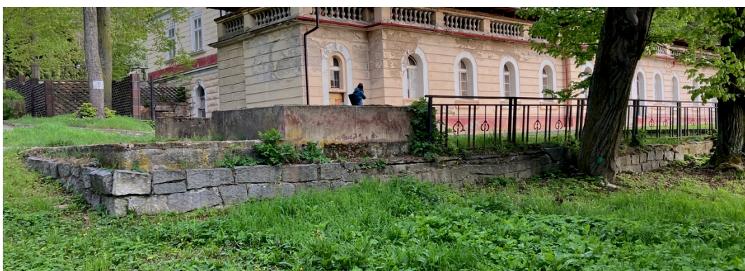
stávající betonová jímka, nízká opěrná zídka a zábradlí k odstranění
